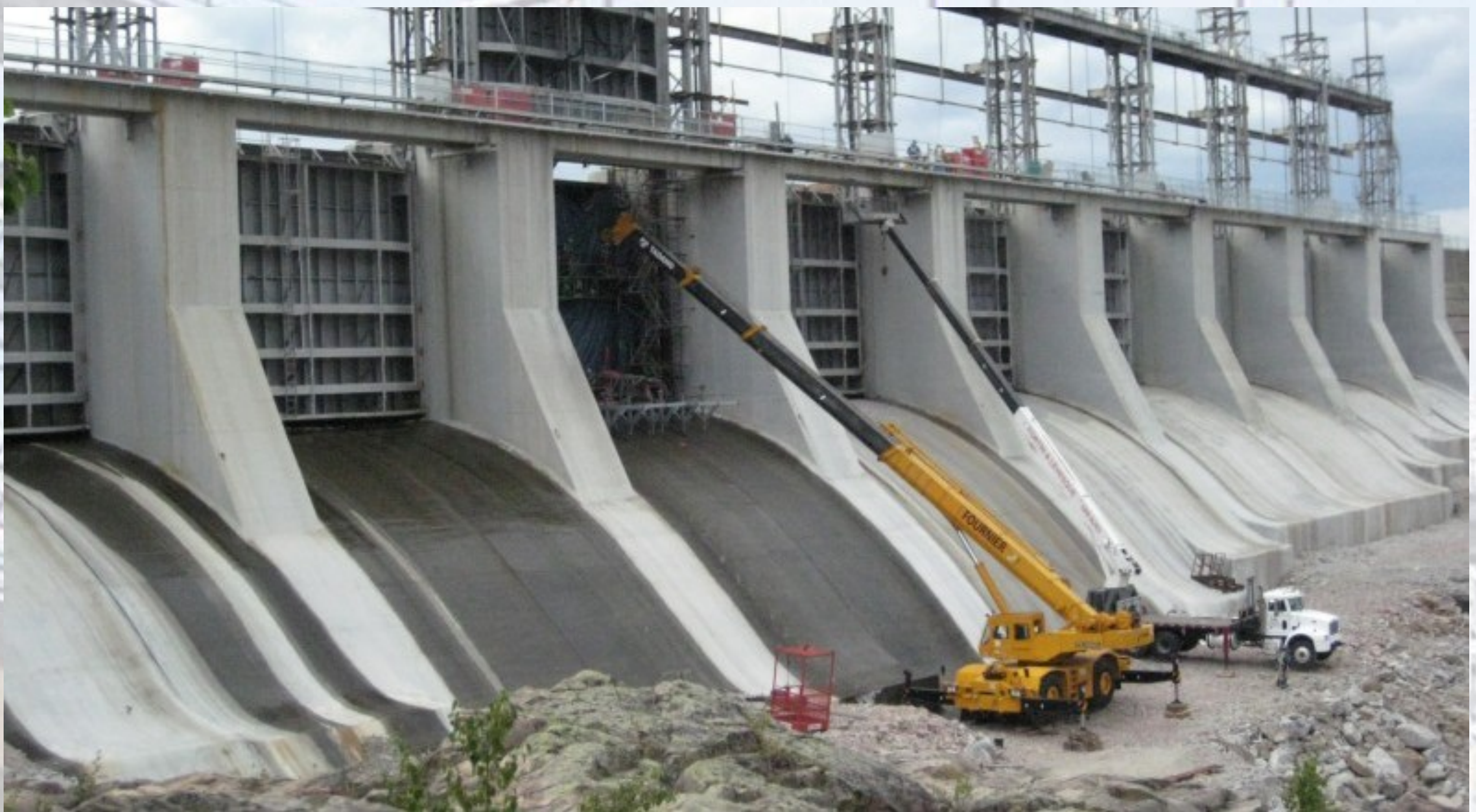
Réfection majeure de l'évacuateur
