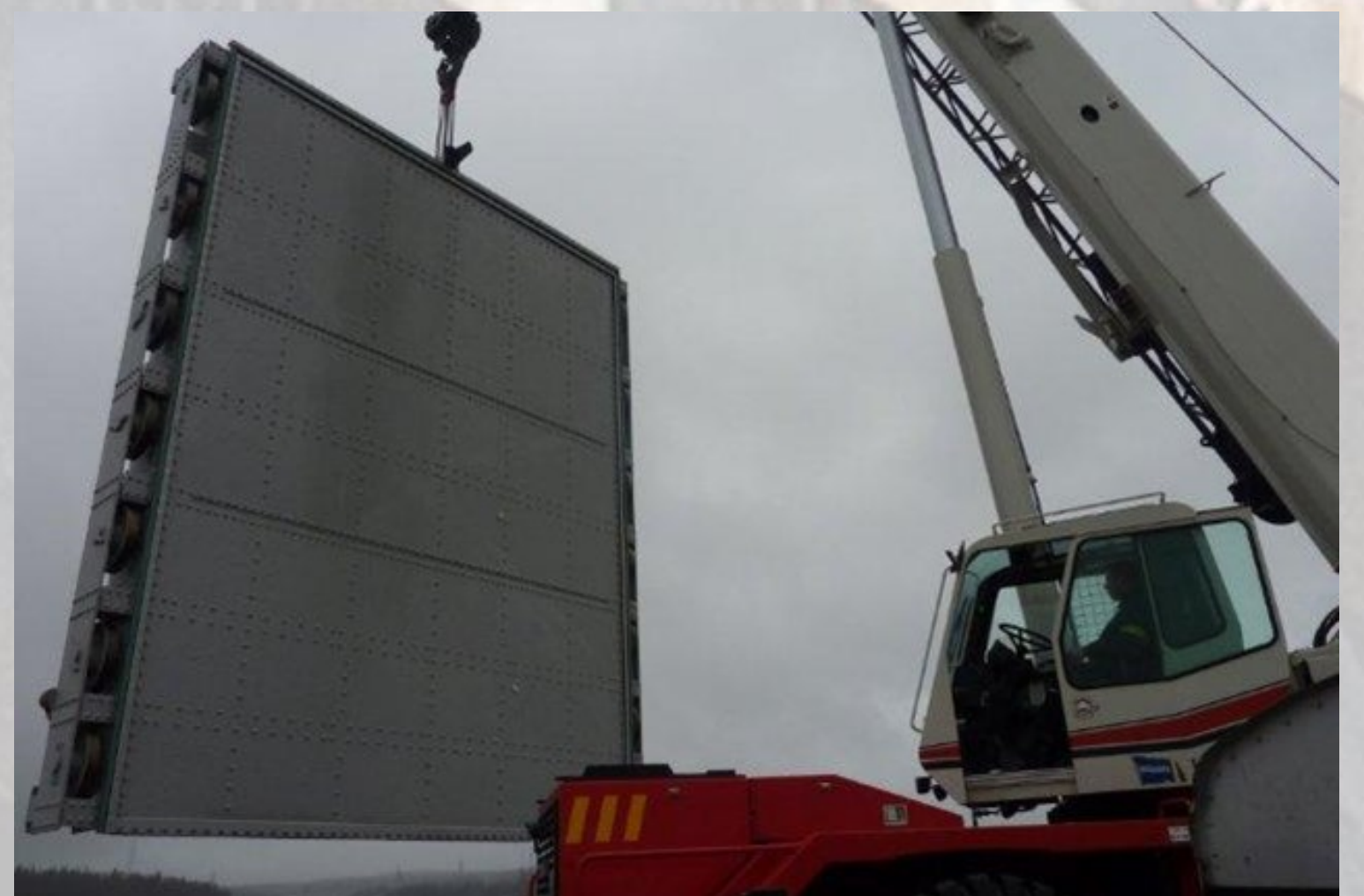
Vanne de prise d'eau réfectionnée
