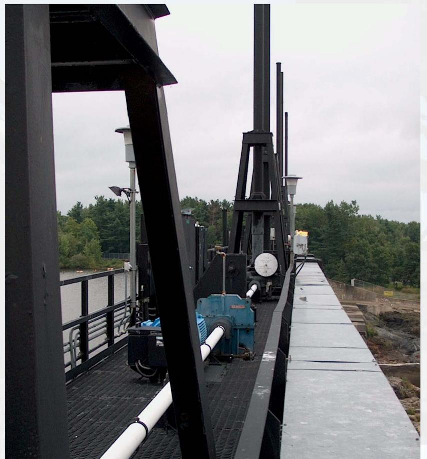
**Système de levage à vis avant réfection**
